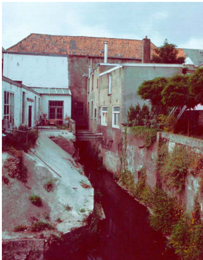
Het verval van de Binnendieze achter de Sint-Jorisstraat is duidelijk zichtbaar, foto omstreeks 1984. Links was Drukkerij de Regenboog gevestigd.
